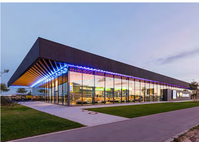
ABB. 10: BEISPIEL EINER TRANSPARENTEN, KOMMUNIKATIVEN FASSADENGESTALTUNG BILD: EDEKA SÜDBAYERN
