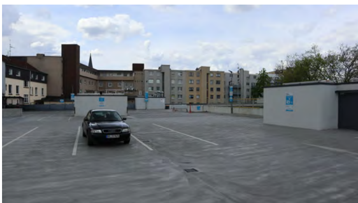
STELLPLÄTZE STELLPLATZANLAGE AUF DEM MARKT
