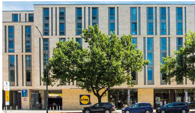
RÄUMLICHER EINDRUCK | EINGANG LIDL-MARKT BILD: SIEMER KRAMER ARCHITEKTEN
