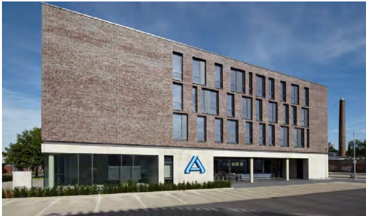
ABB. 11: IN DAS GEBÄUDE INTEGRIERTE UNTERBRINGUNG VON EINKAUFSWAGEN; BILD: WANNENMACHER MOELLER ARCHITEKTEN
