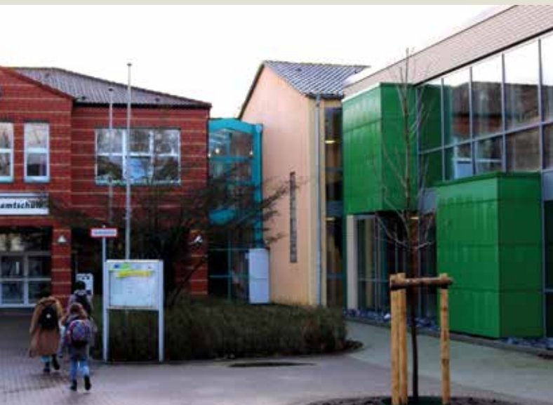
Neubau eines Klassentraktes an der Sophie-Scholl-Gesamtschule
