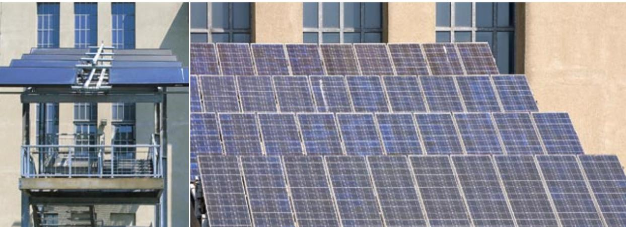
▲ Solartechnik für die Warmwassernutzung (links) und die Stromproduktion (rechts) nebeneinander an einem Gebäude
