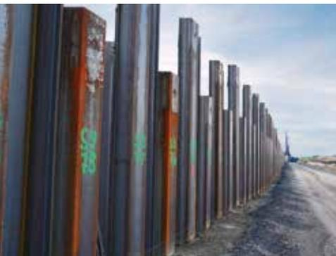
Für die neue Hochwasserschutzanlage wurden Spundbohlen in den Untergrund eingesetzt, die später noch weiter in die Tiefe getrieben wurden.
