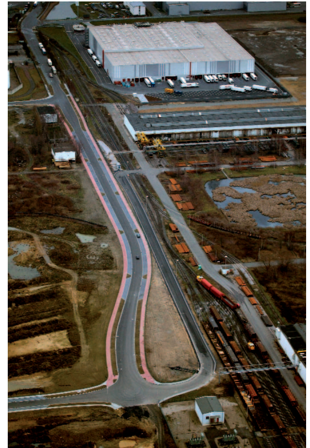
Kanaltrasse: 1. Bauabschnitt bis MHP (2005)
