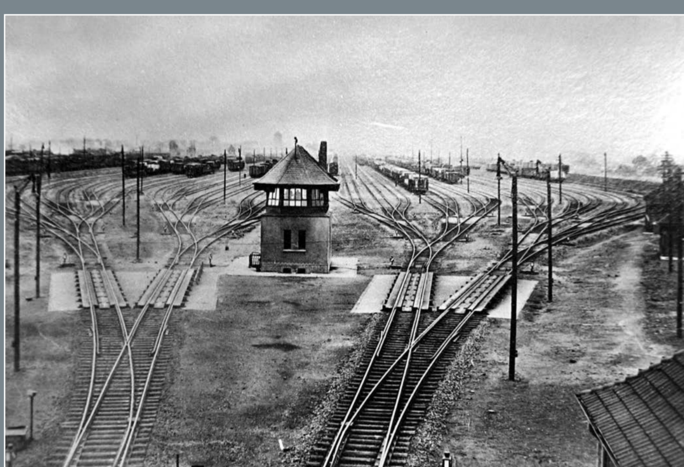
Ablaufanlage Hamm-Verschiebebahnhof- West Hvw mit Bremsturm und Gleisbremsen, um 1930 | RBD Essen
