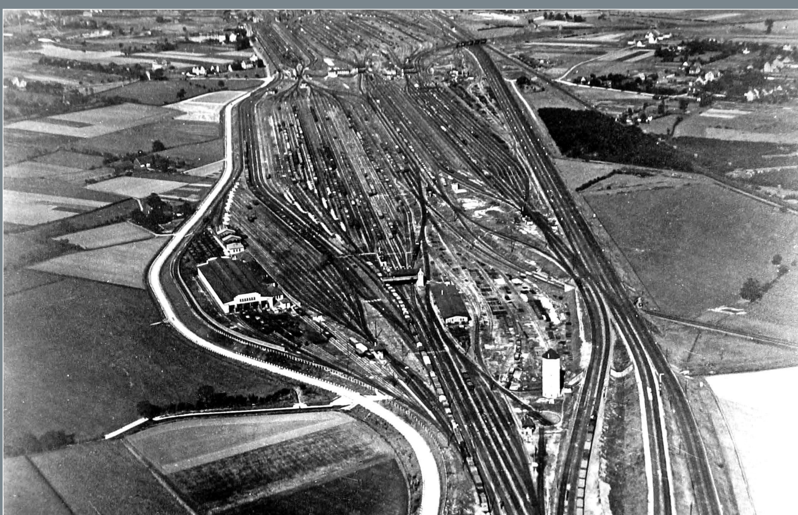
Der größte Verschiebebahnhof Europas im Jahre 1927: 9,3 km lang, 470 m breit, mit 20 elektromechanischen Stellwerken für 1.100 Weichen und 160 Signale | Stadtarchiv Hamm
