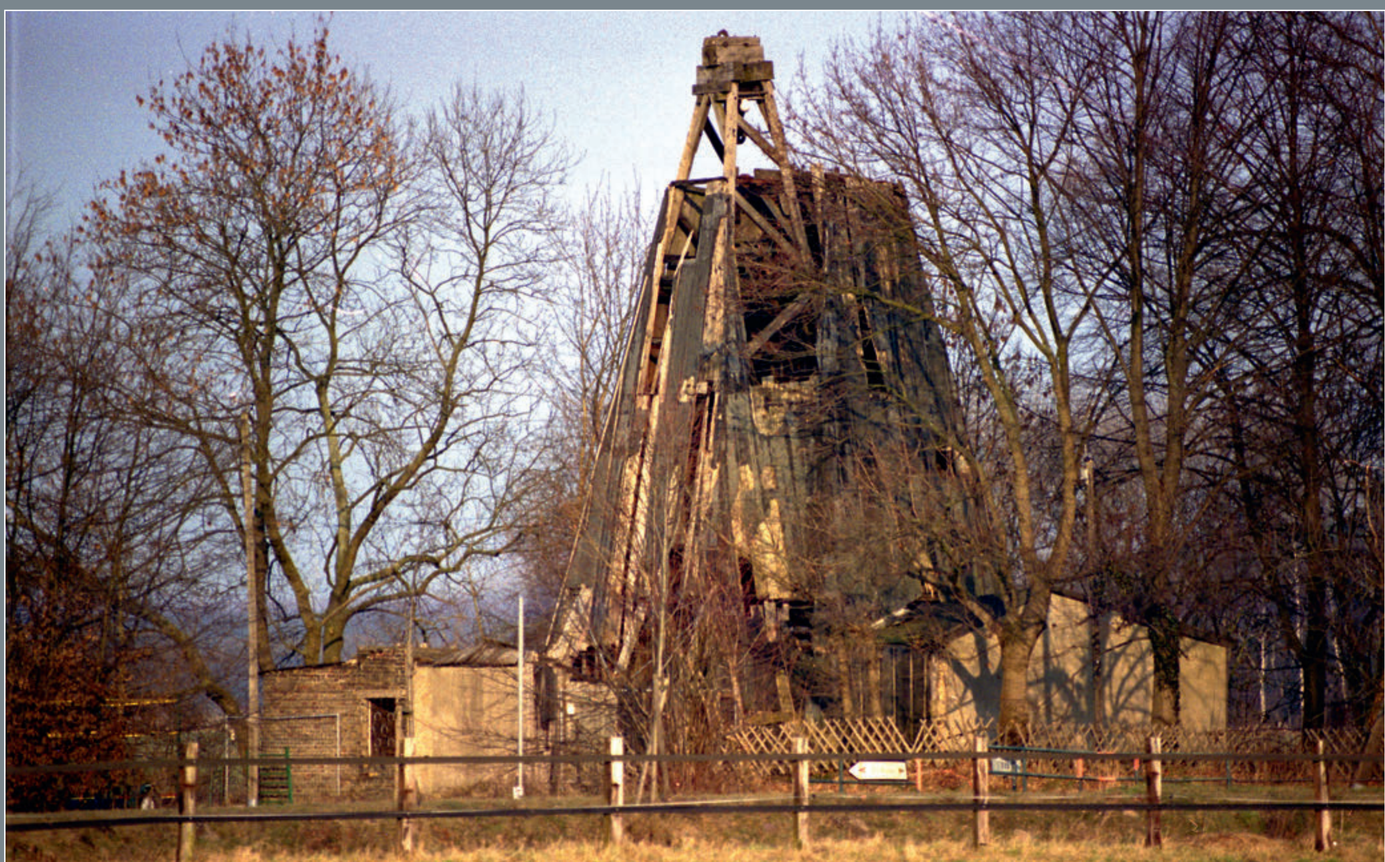
Solebohrturm und Nebengebäude, Zustand im Februar 2009 | © Stephan Mohr
