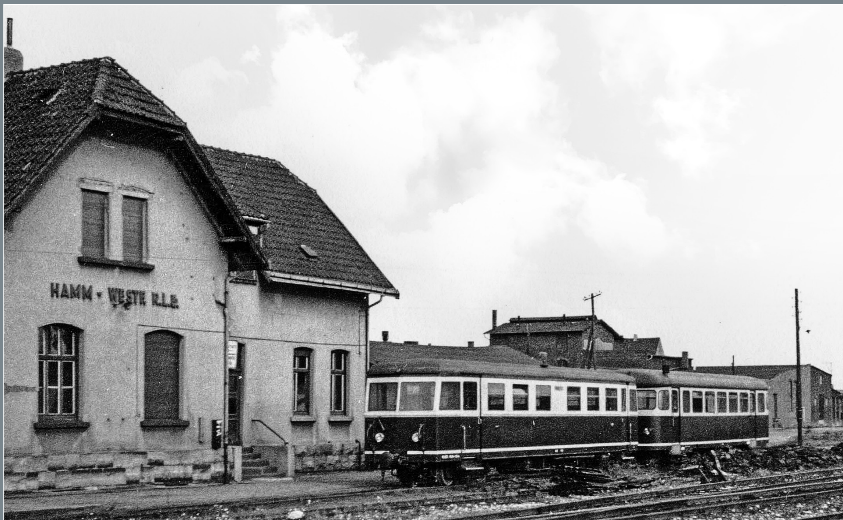
Das Empfangsgebäude des Bahnhofs Hamm (Westf.) RLE im Zustand um 1960 | Sammlung Dr. Meinold
