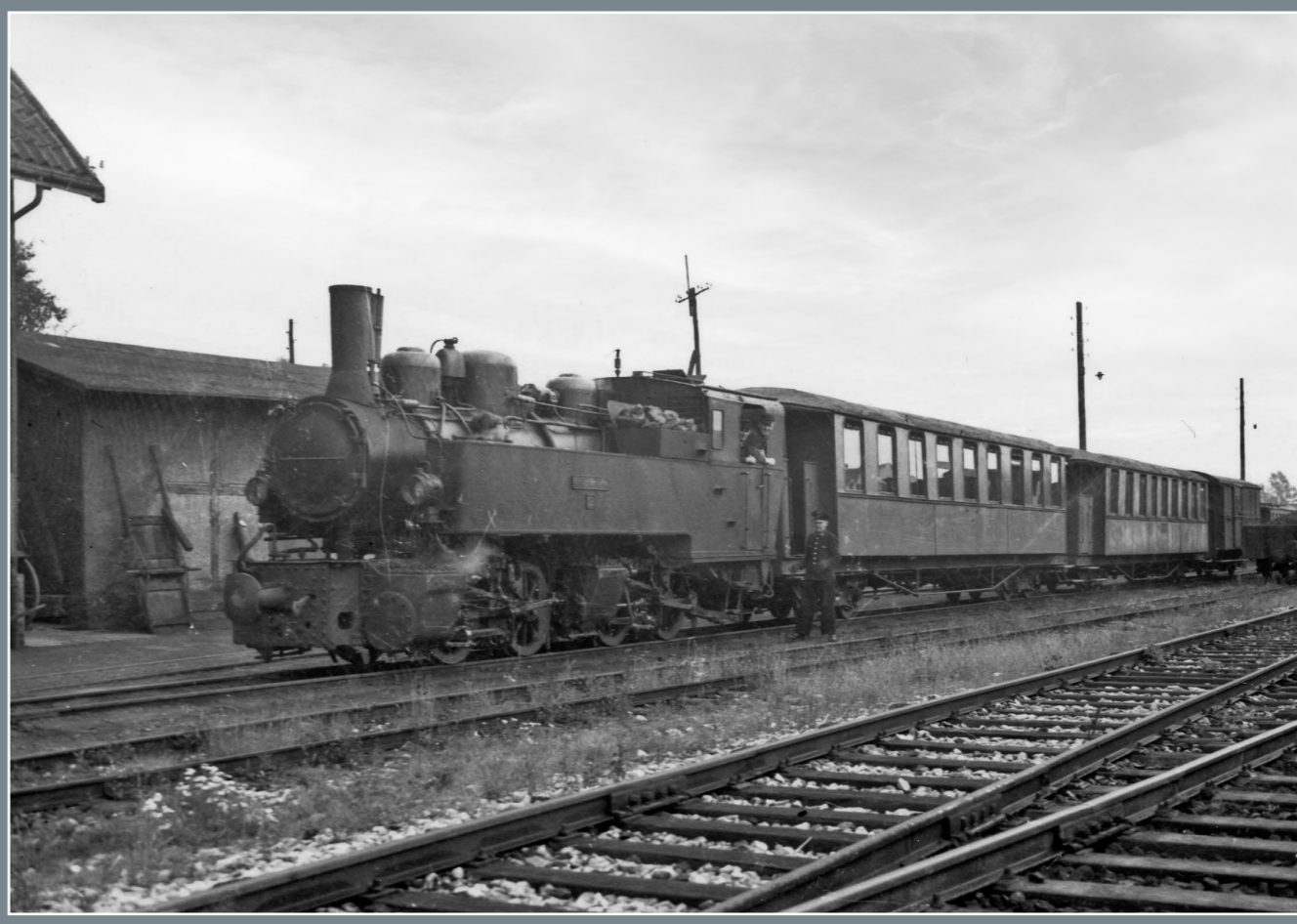
Bis in die 1950er-Jahre wurden die Züge auf der RLE mit Dampflokomotiven befördert. Hier steht Lok 12 im Bahnhof Hamm (Westf.) RLE, 31. Juni 1953. | S. Overbosch, Sammlung Dr. Meinold
