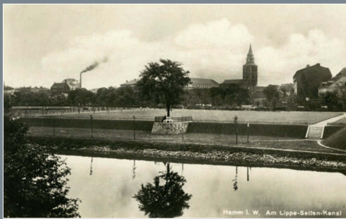
Der östliche Teil des Nordrings vom Lippe-Seiten-Kanal aus gesehen | Stadtarchiv Hamm
