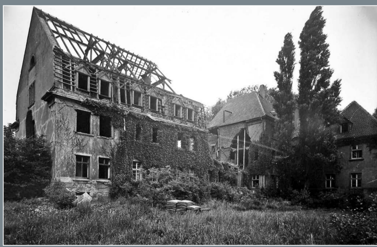
Kriegsbeschädigtes Übernachtungsgebäude, 1948 | RBD Essen
