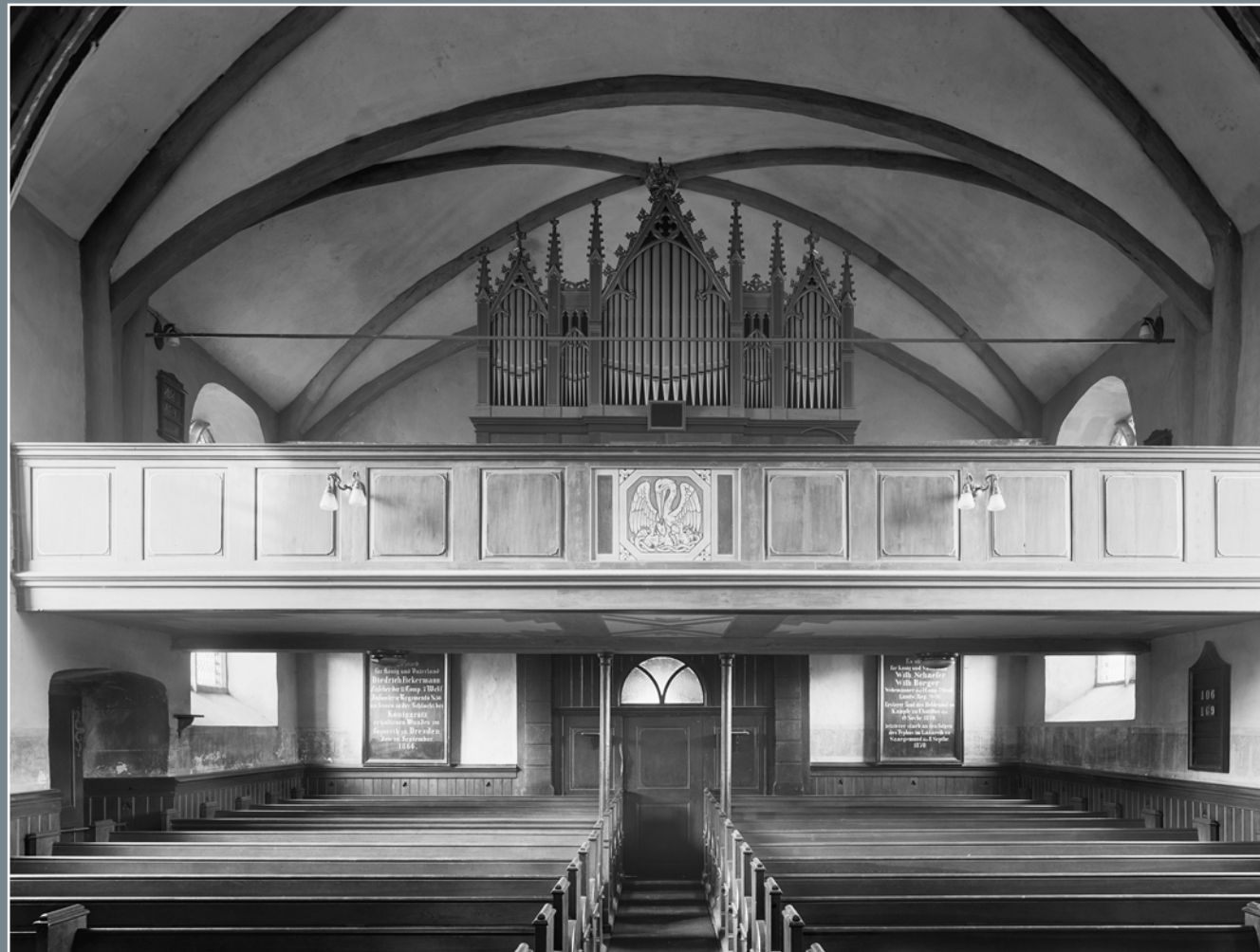
Innenansicht der Jakobuskirche mit Blick nach Westen auf die Empore mit Orgel LWL-Denkmalpflege, Landschafts- und Baukultur in Westfalen
