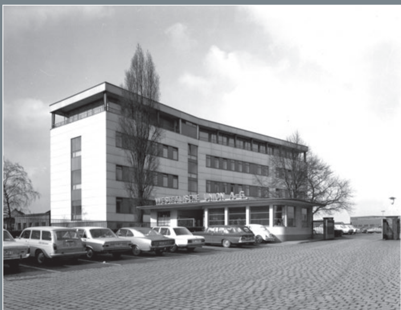
Verwaltungsgebäude und Werkseingang der Westfälischen Union, 1970er-Jahre | © Gerda Jucho, Slg. Stadtarchiv Hamm
