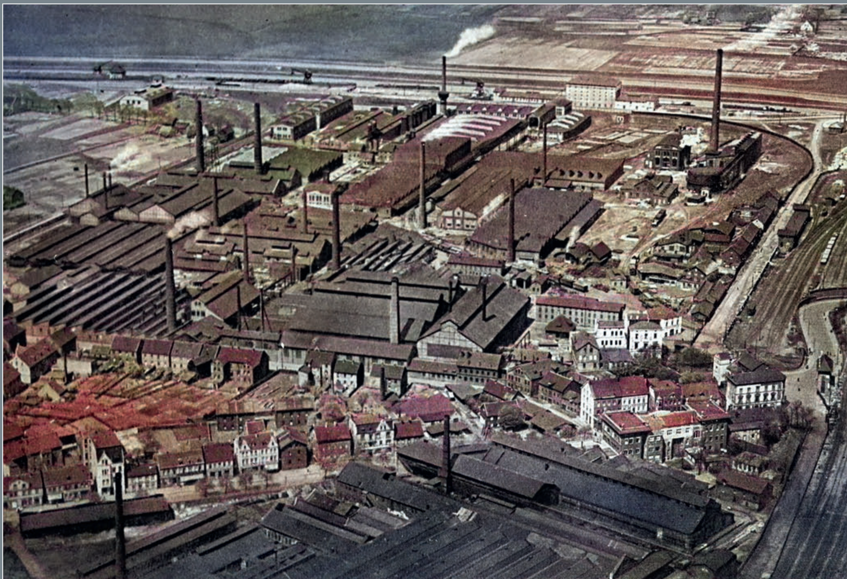
Fliegeraufnahme der Anlagen in Hamm der Phoenix-Aktiengesellschaft für Bergbau und Hüttenbetrieb, Abteilung Westfälische Union, Hamm i. Westf., um 1920 | Repro: Gerda Jucho, Slg. Stadtarchiv Hamm
