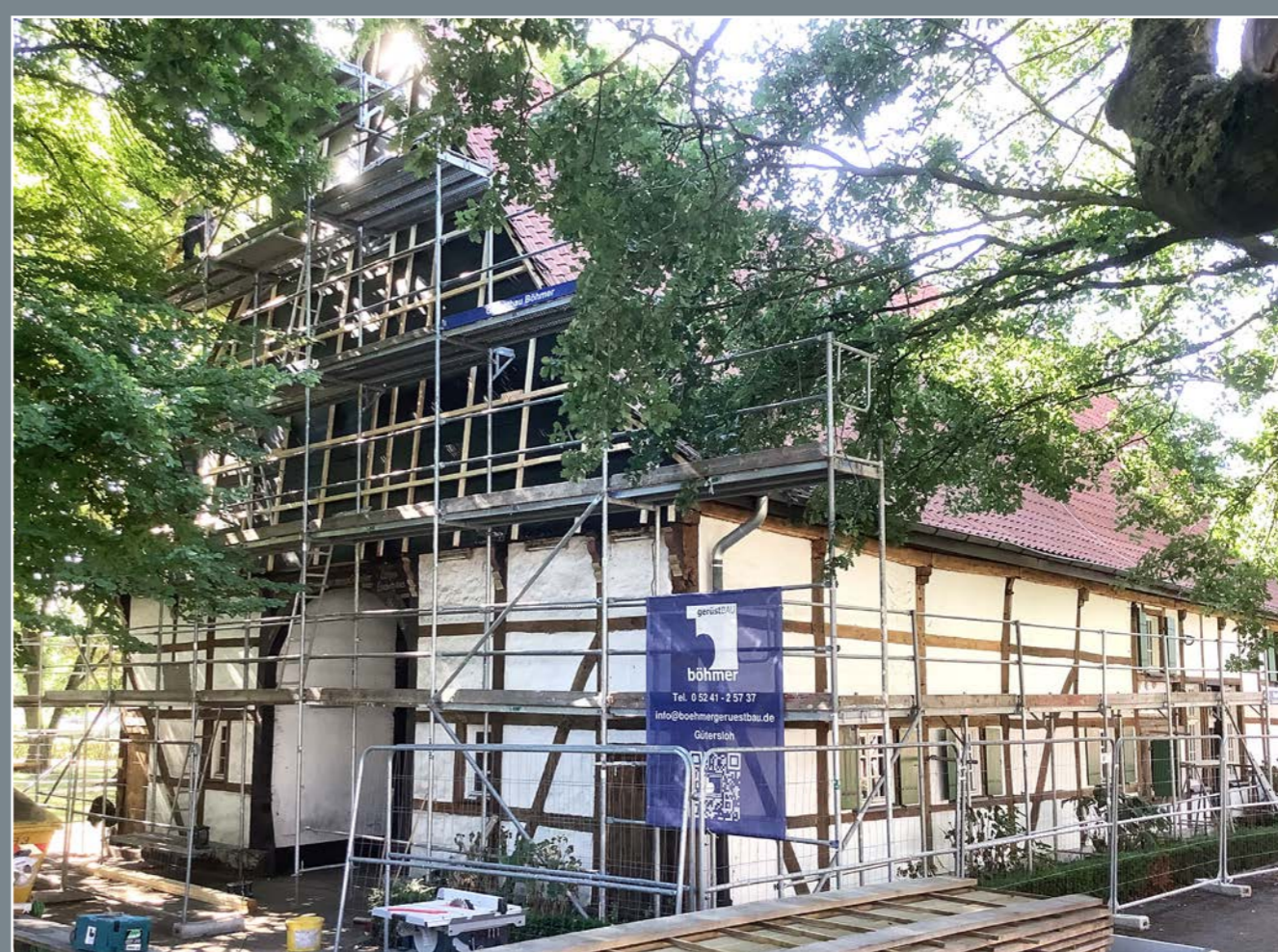
Sanierung des Brokhofes im Jahre 2022 Stadt Hamm, Immobilienmanagement
