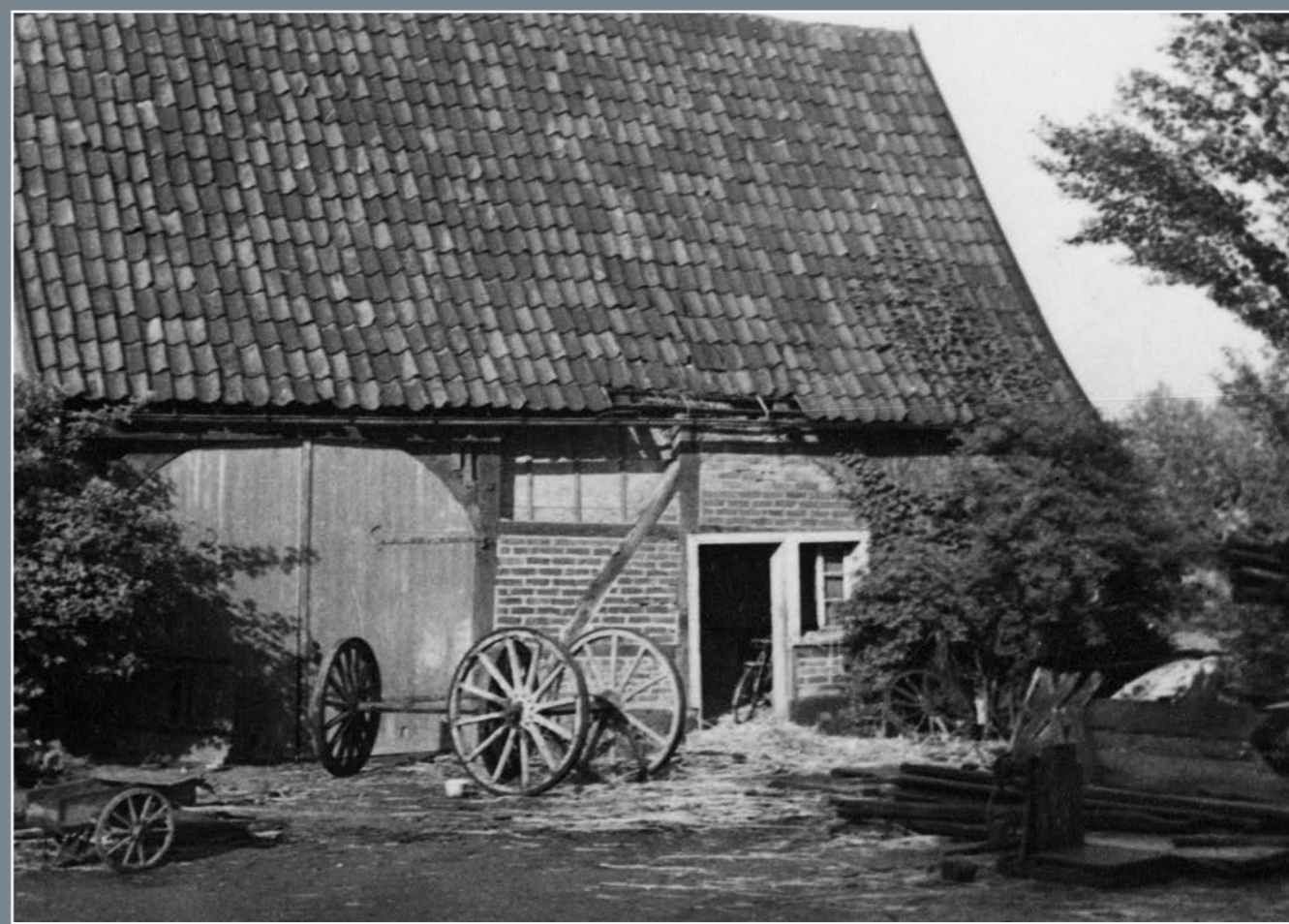
Remise/Scheune zu Beginn der 1950er-Jahre Stadtarchiv Hamm
