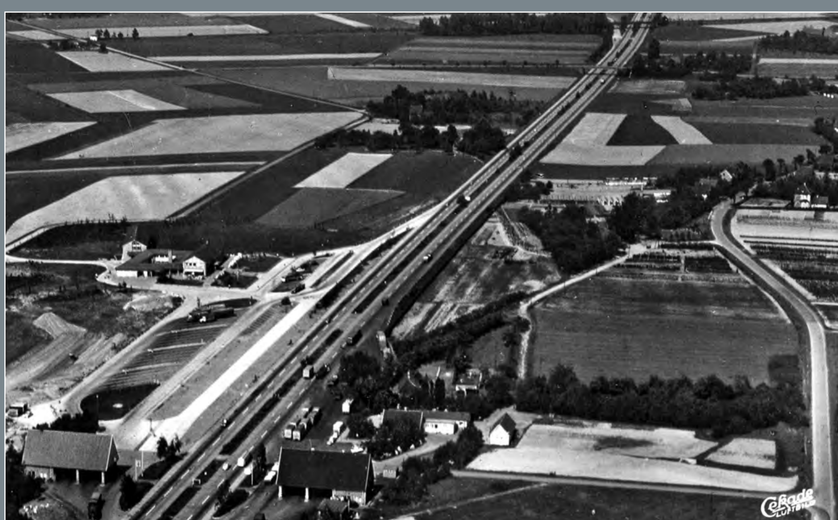
Luftbild Autobahnraststätte Rhyern, Ende 1950er-Jahre | Stadtarchiv Hamm Am oberen Bildrand ist unterhalb der Eisenbahnbrücke die Einschleifung der RAB-Strecke 77 zu erkennen.
