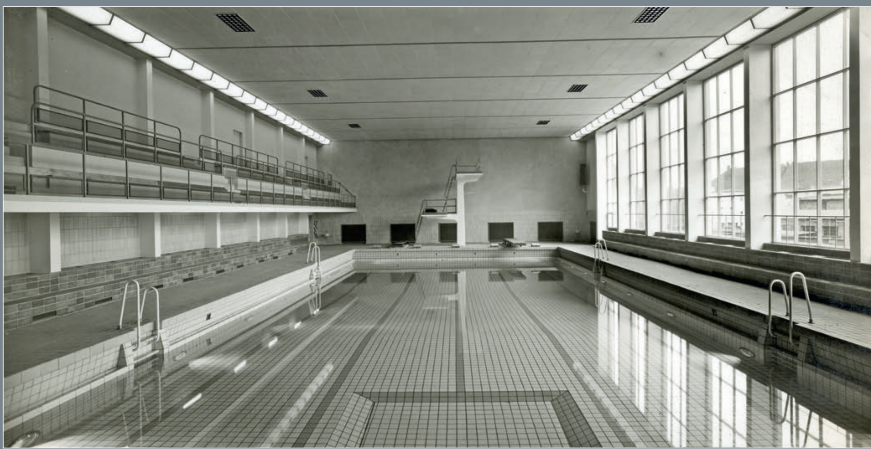
Am 15. Dezember 1956 wurde das wiederaufgebaute Stadtbad eröffnet. | Stadtarchiv Hamm
