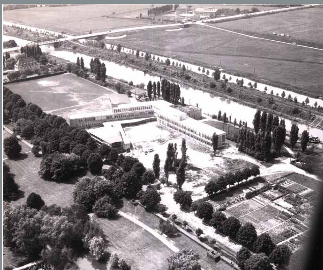
Der Neubau des Gymnasiums Hammonense an der Berliner Allee (heute Adenauerallee), 1956 | Stadt Hamm, Vermessungs- und Katasteramt
