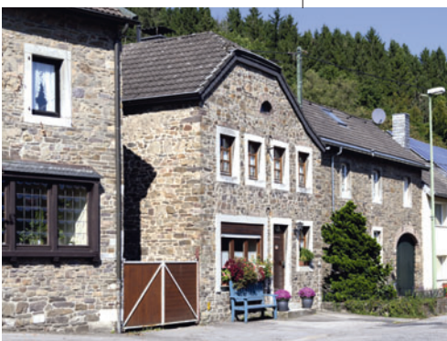
Bruchsteinhaus in Roetgen-Mulartshütte. Bruchstein ist ein regionaltypisches Baumaterial im Aachener Raum und in der Nordeifel. © LVR-Amt für Denkmalpflege im Rheinland, Margrit Wolf
