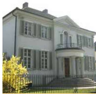
■ Villa Ostenallee 68 Quelle: UDB, Stadt Hamm
