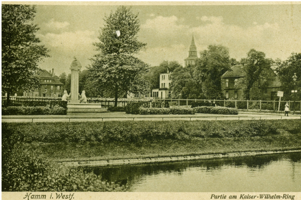
Abb. 5: Blick vom ehemaligen Wasser-Bassin am Otto-Krafft-Platz auf den Bärenbrunnen. Bis auf das 1915/16 errichtete Wohnhaus Nr. 5/6 sind die angrenzenden Baufelder noch unbebaut und mit einem Zaun abgesperrt. Das Wasser-Bassin wurde in der Nachkriegszeit verfüllt. Quelle: Stadtarchiv Hamm.
