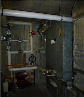
Abluftanlage mit einem Volumenstrom von 3800m<sup>3</sup>/h
