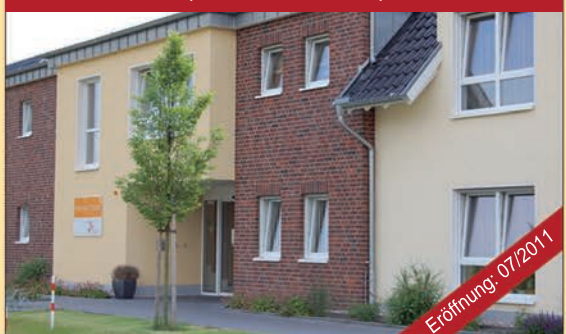
Haus von Thünen | Von-Thünen-Str 57a | Hamm-Westtünen
