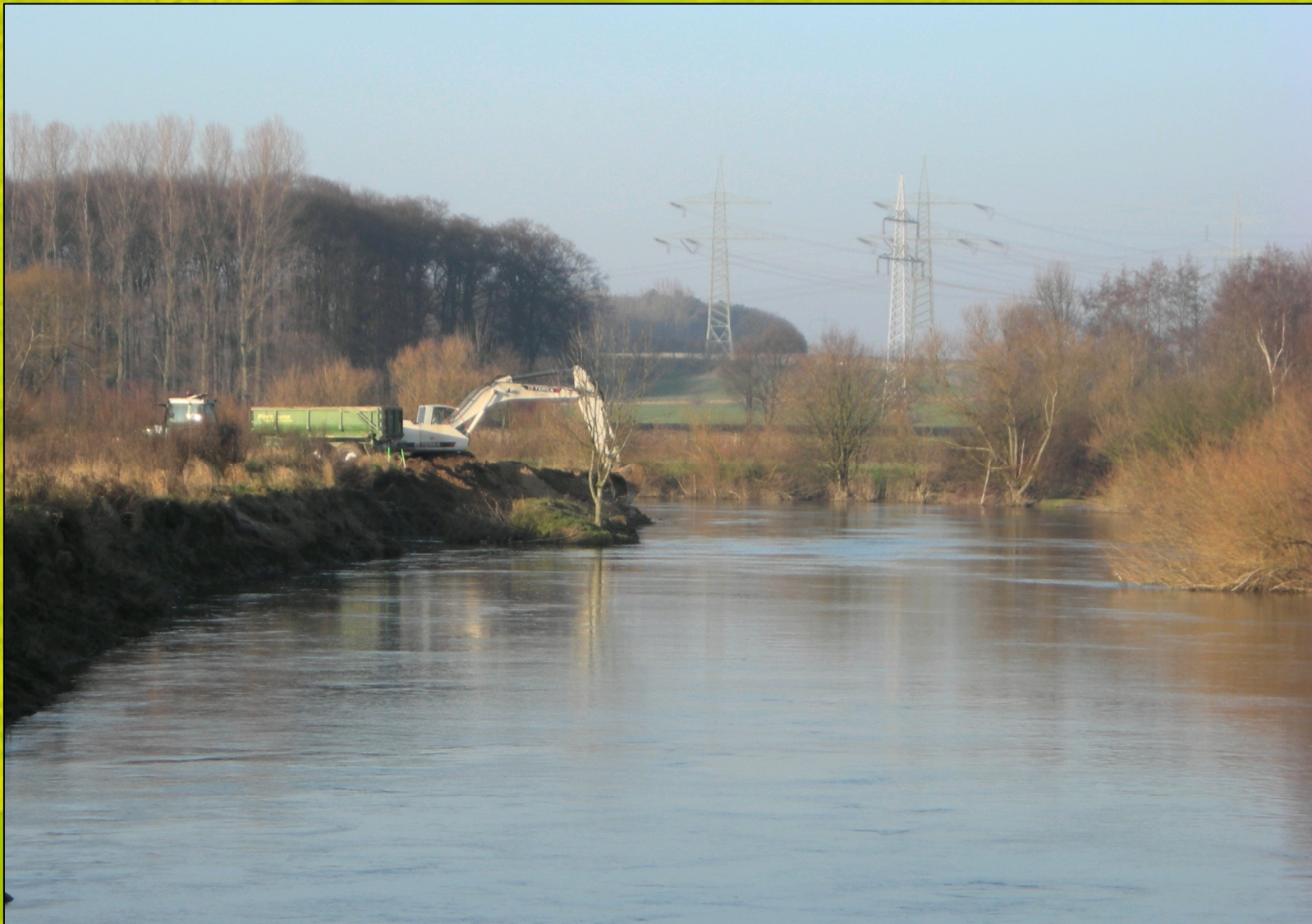
Uferentfesselung per Baggerarbeit
