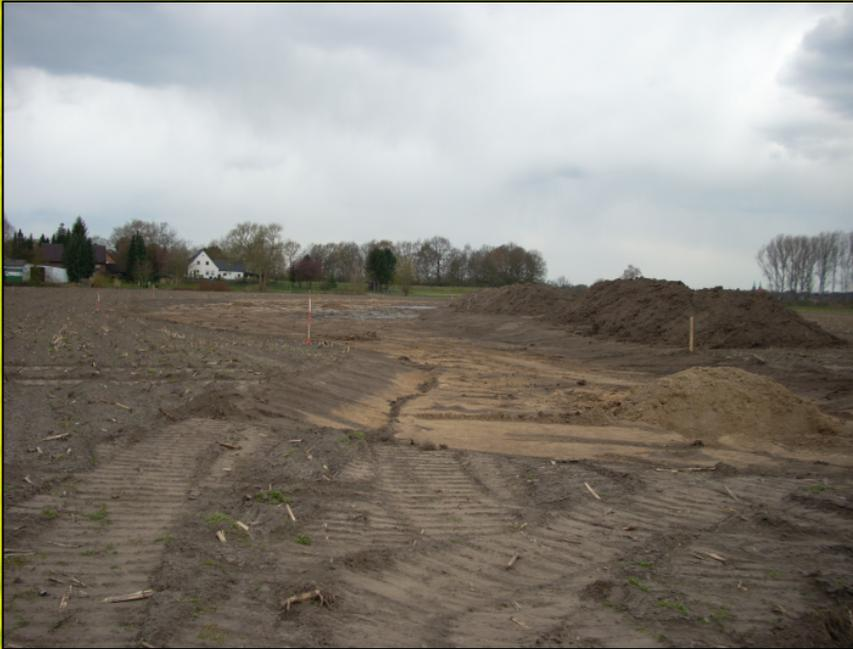
Die Böschungen im hinteren Bereich der Flutmulde wurden sehr flach ausgezogen (Bilder links), während der Einlauf zur Lippe als Steilufer geformt wurde (Bild unten).
