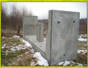
Bild unten: Zur Sicherung des Bereiches in dem bis zu 1.000 I Lippewasser pro Sekunde einlaufen wird ein Betonprofil eingebaut. Damit bietet sich die Möglichkeit eine Metallreuse einzubauen, mit deren Hilfe die Fische gezählt werden können. So kann die Funktionstüchtigkeit des Gerinnes überprüft werden.
