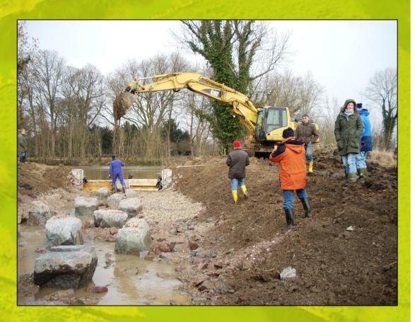
Bild oben links: Ein letzter Damm wird mit zwei Baggern gleichzeitig abgegraben.
