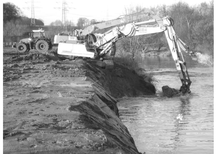
Entnahme des Deckwerkes („Entfesseln“ der Ufer) mit schwerem Gerät (November 2006).
