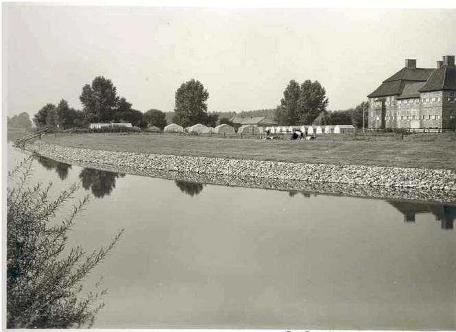
Fotografie vom 9.9.1969 direkt nach dem Ausbau des Nordufers bei Schloss Oberwerries (Blockschüttung als Deckwerk zur Befestigung der Ufer entlang der Wasserlinie)
