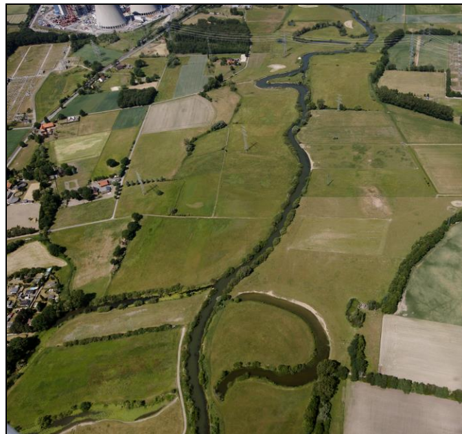
Luftbild von der Heidemühle vor der Umsetzung der Baumaßnahmen (Foto: Hans Blosssey)
