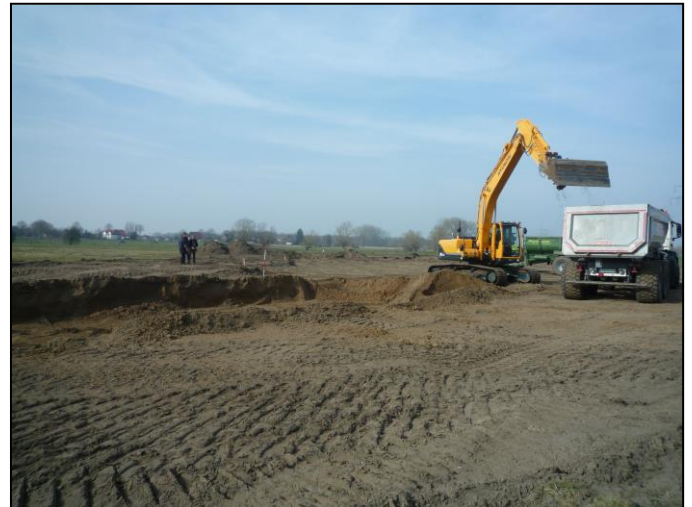
Kettenbagger beim Ausheben der Flutmulde (Foto: Holger Ruhmann)
