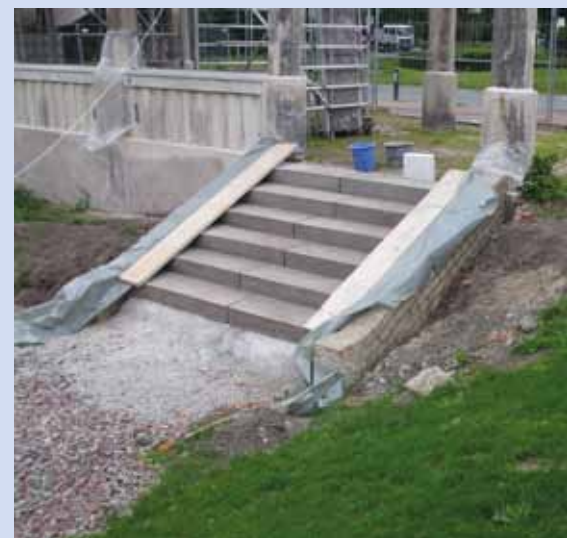
Restaurierung der Treppenanlage
