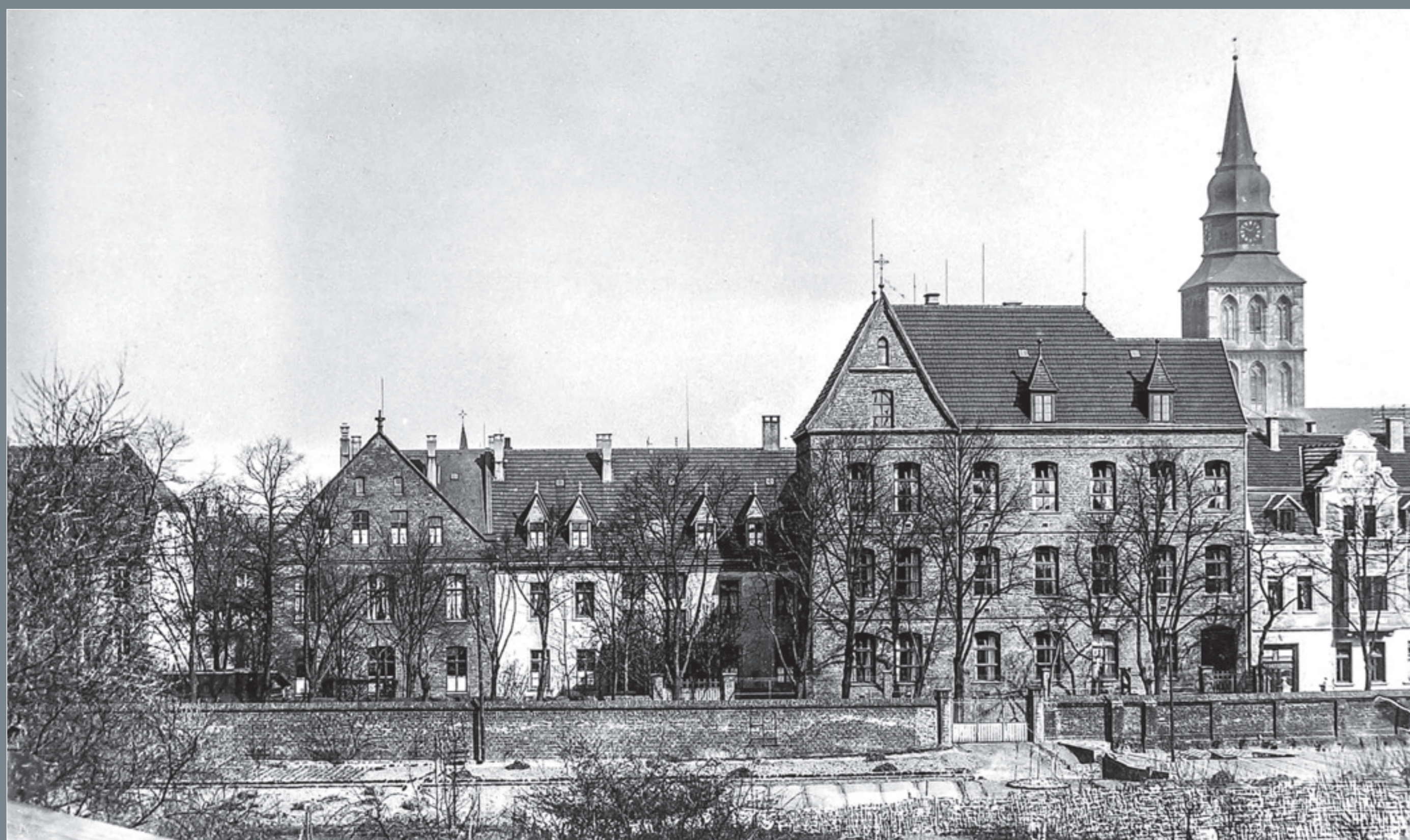
Blick von Süden auf das Katholische Krankenhaus, um 1910 | Stadtarchiv Hamm
